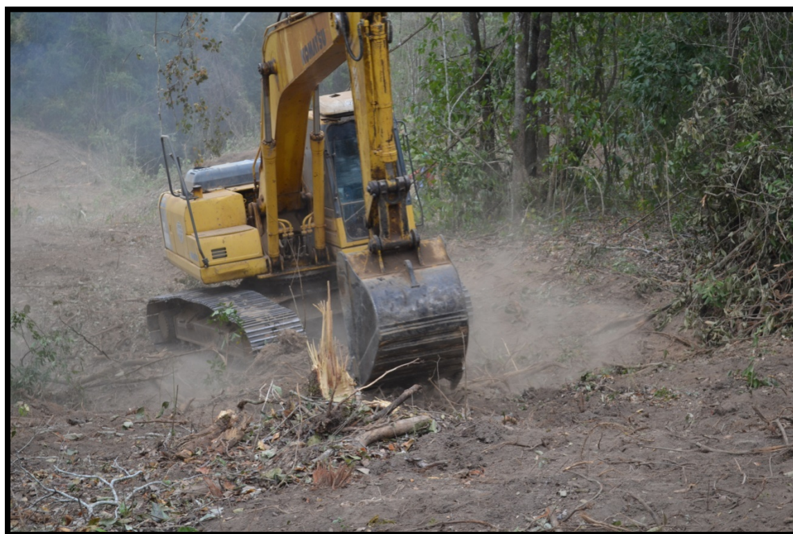
FIGURA 05. Escavadeira de esteiras durante supressão vegetal.
