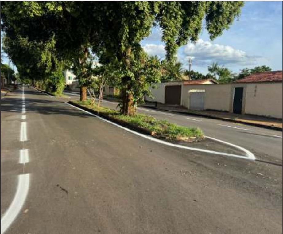
Ano de 2025 já se iniciou com ruas sendo recuperadas nos bairros da cidade
