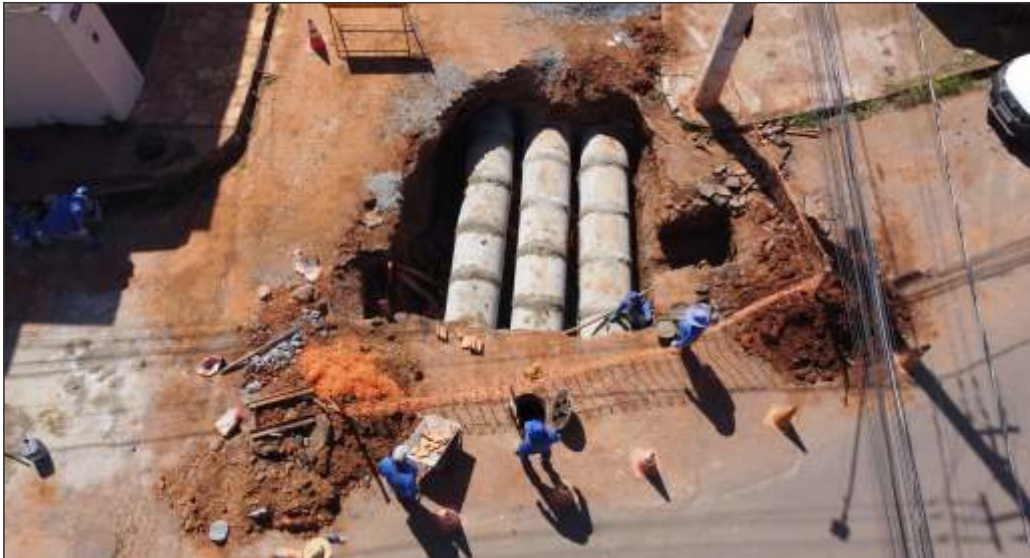
Investimos também na ampliação de nossas redes de esgoto
