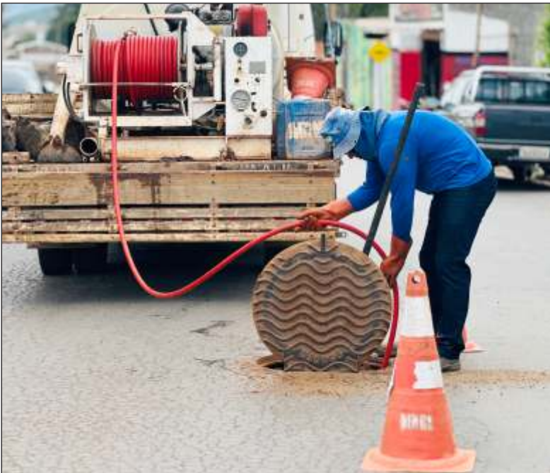
Saae realiza constantemente a limpeza preventiva de esgoto
