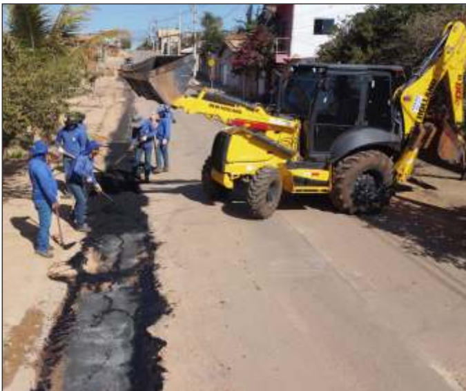
Ampliação da rede no bairro Cidade Nova permitiu levar água tratada para o bairro Sagrada Família
