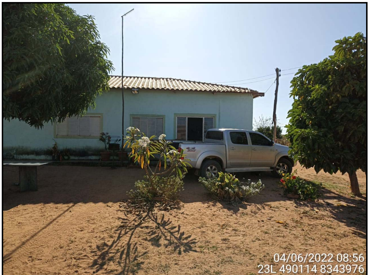
Figura 8 – Residência que deverá passar por adequação, instalação de fossa séptica ou de biodigestor.
