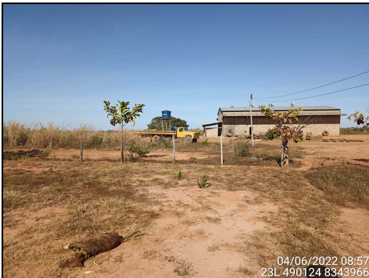
Figura 6 – Vista geral do barracão de máquinas.
