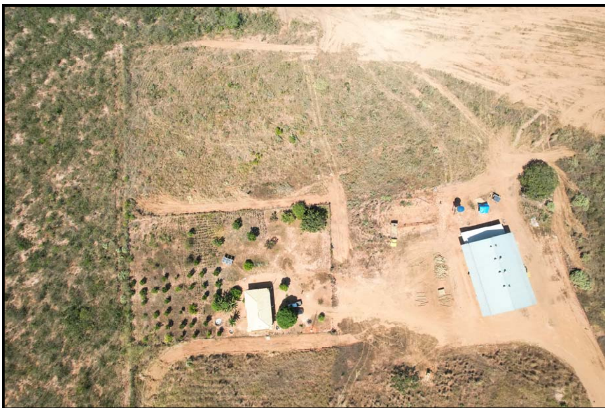
Figura 7 - Infraestrutura existente no empreendimento.
